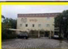
Proj. 045 Piso Vinílico em 3 Salas de Aula AMCIP - R$ 5.389,01
