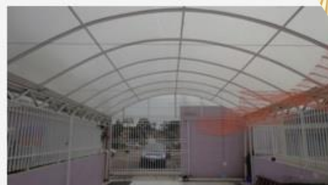
Proj. 025 - Cobertura do C.E.I. Vovó Cenira Gusso - R$ 10.000,00
